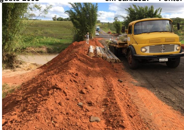
Foto 6.7 – Ponte em reconstrução – Obra realizada pela conexão da rodovia
