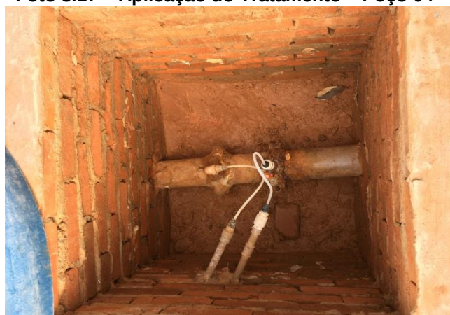
Foto 3.19 – Aplicação do Tratamento – Poço 05
