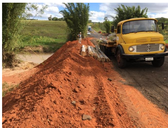
Foto 3.68 – Reconstrução da ponte destruída
