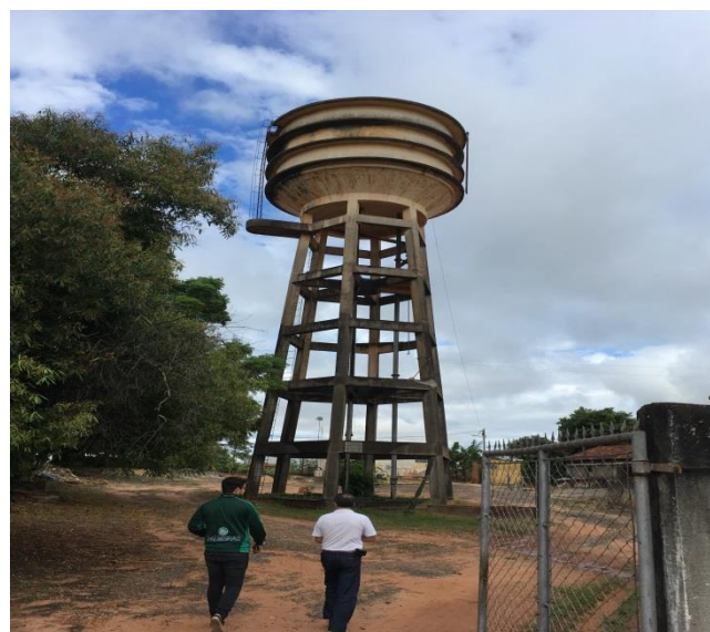
Foto 3.39 – Reservatório – Caixa D'Água
