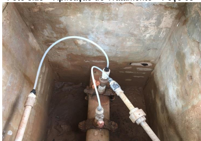
Foto 3.17 – Aplicação do Tratamento – Poço 04
