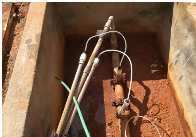
Foto 3.21 – Aplicação do Tratamento – Poço 06
