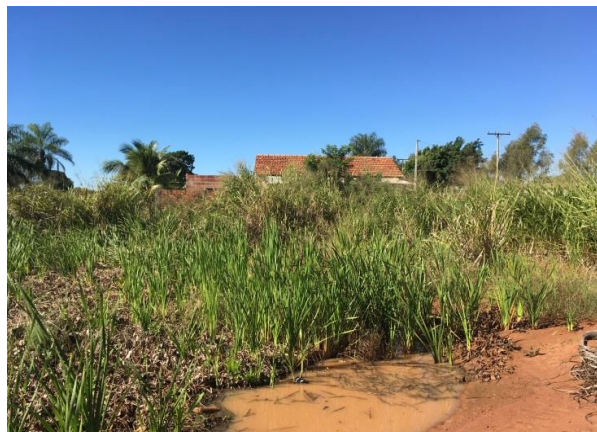
Foto 3.60 – Bacia de retenção
