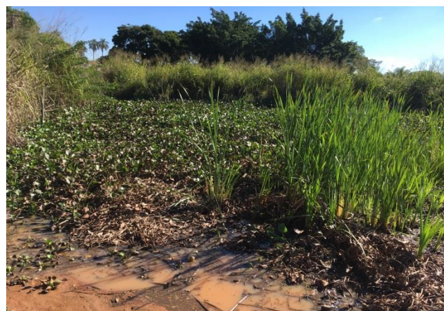
Foto 3.58 – Bacia de retenção
