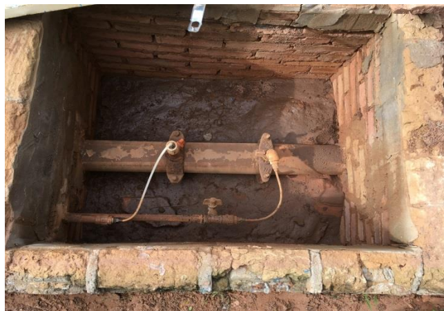
Foto 3.15 – Aplicação do Tratamento – Poço 03
