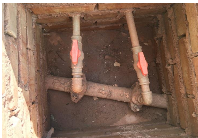
Foto 3.33 – Aplicação do Tratamento – Poço 16
