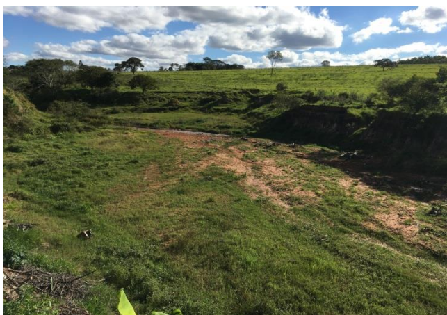
Foto 3.71 – Erosão próxima à ETE 1
