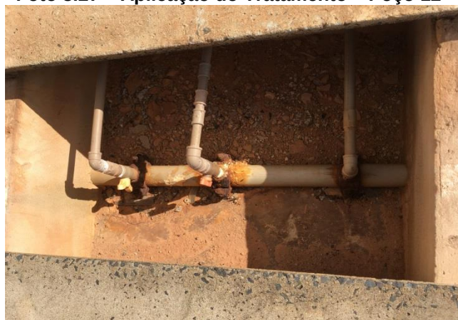
Foto 3.29 – Aplicação do Tratamento - Poço 13
