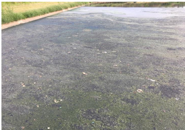
Foto 6.1 – Sobrenadante na lagoa anaeróbia da ETE 1
