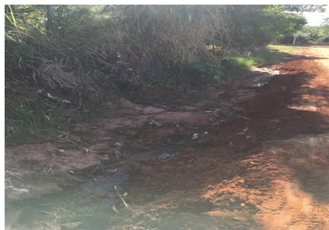
Foto 3.76 – Término da erosão
