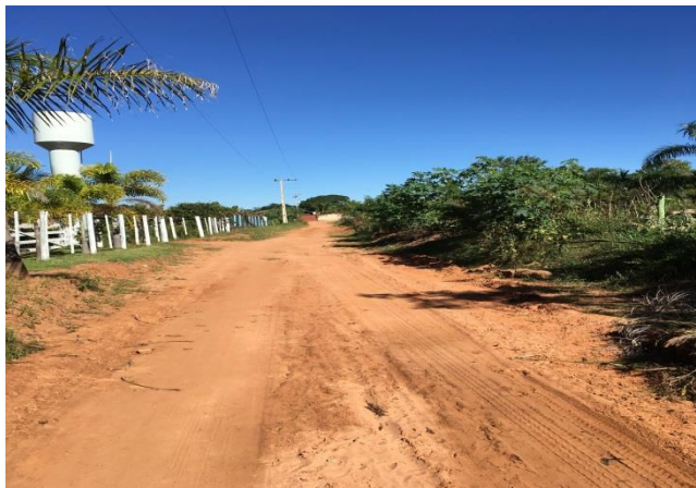
Foto 3.64 – Rua intransitável devido à alagamentos – Bairro Bandeirantes
