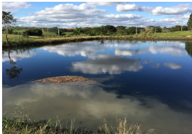
Foto 3.50 – Lagoa Anaeróbia – ETE 2
