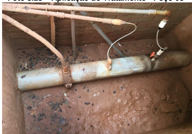
Foto 3.25 – Aplicação do Tratamento – Poço 09
