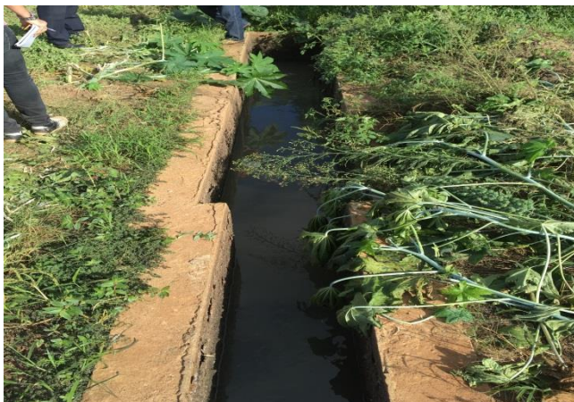
Foto 3.49 – Tratamento Preliminar – ETE 2
