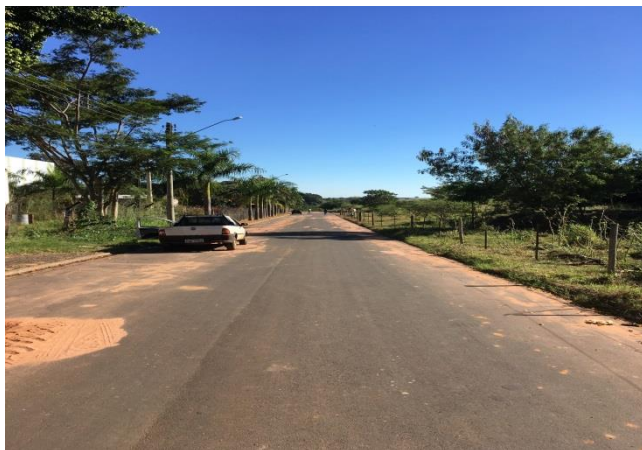
Foto 3.53 – Avenida Dionisio Mota
