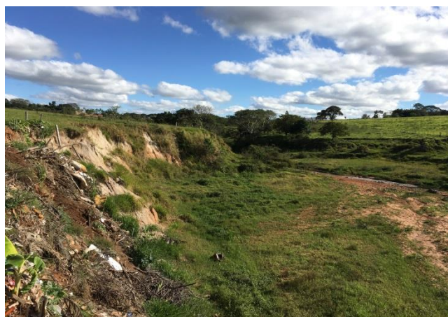
Foto 3.72 – Erosão próxima à ETE 1
