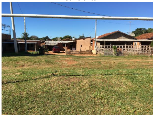
Foto 3.63 – Moradias que sofrem danos com inundações no cruzamento
