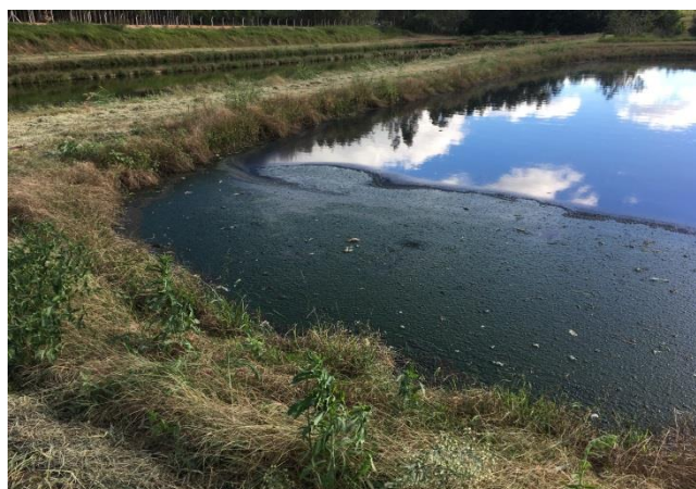
Foto 6.4 – Início do acúmulo de sobre-nadante na ETE 2
