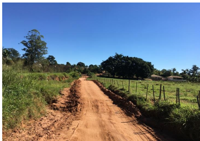
Foto 3.66 – Rua de acesso. Ponto de alagamento na região mais escura
