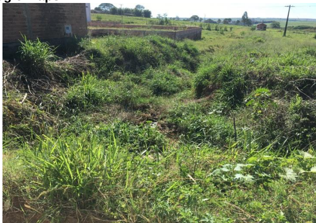
Foto 3.80 – Visão ampla da erosão na Av. Brasil
